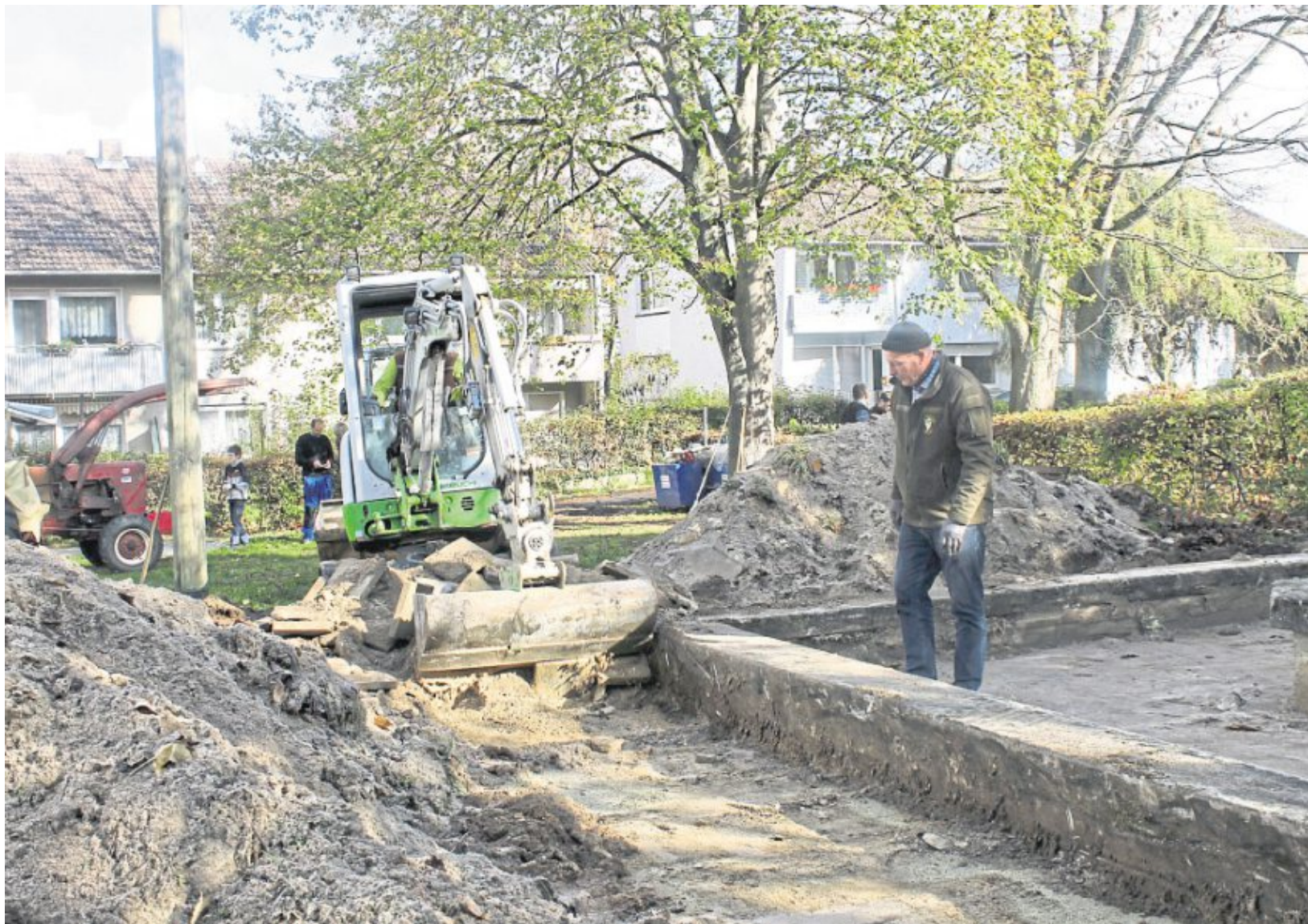
Axel Fickeis betrachtet die Baggerarbeiten am früheren Springbrunnen an der Lübener Straße. Der Unterbau, der einst sehr massiv gestaltet wurde, wird jetzt entfernt, damit dort der geplante Generationengarten entstehen kann.
